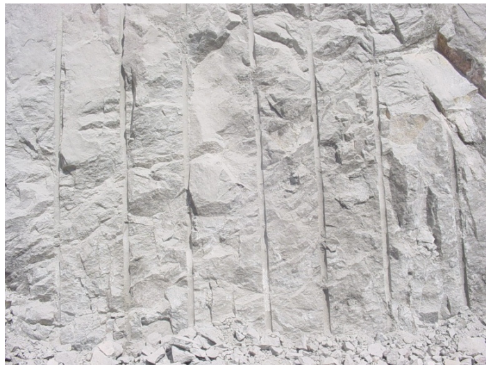
Figura 2. Precorte en taludes.
