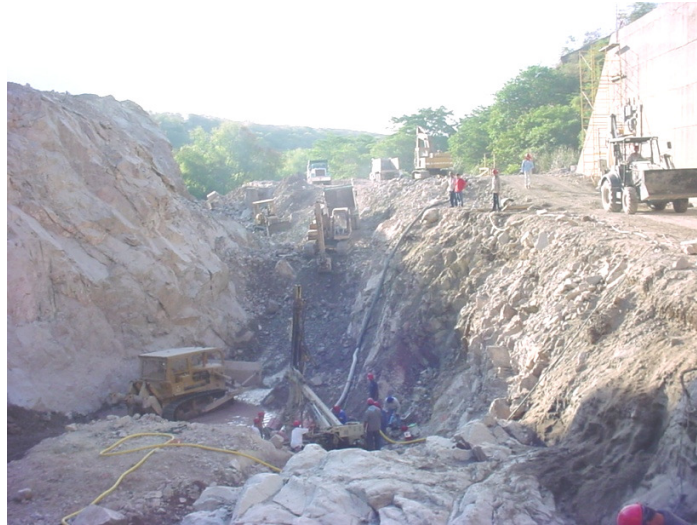
Figura 3. Barrenación.
