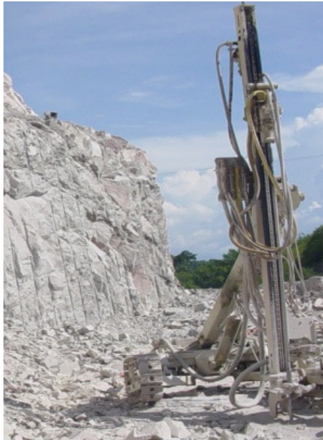
Figura 1. Equipo de perforación Track-Drill.
