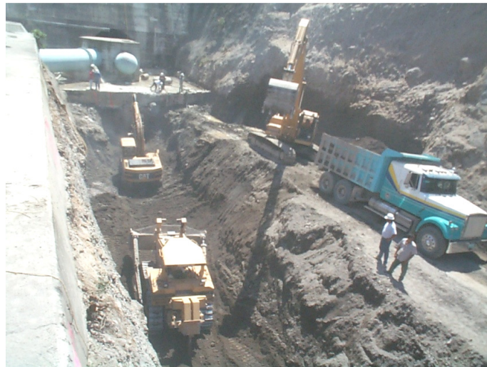
Figura 4. Retiro de material producto de voladoras.
