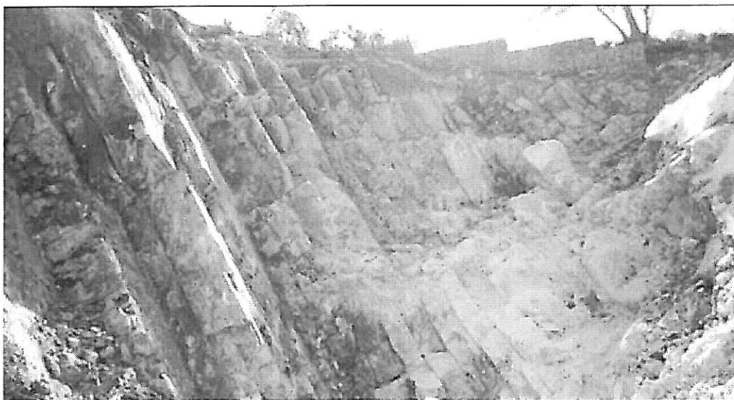
Calizas Cretácicas en el sitio del portal de salida del túnel (vista aguas arriba)
